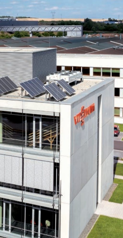
Das neue Schulungs- und Vertriebszentrum in Faulquemont entspricht höchsten Nachhaltigkeitsstandards (links).
